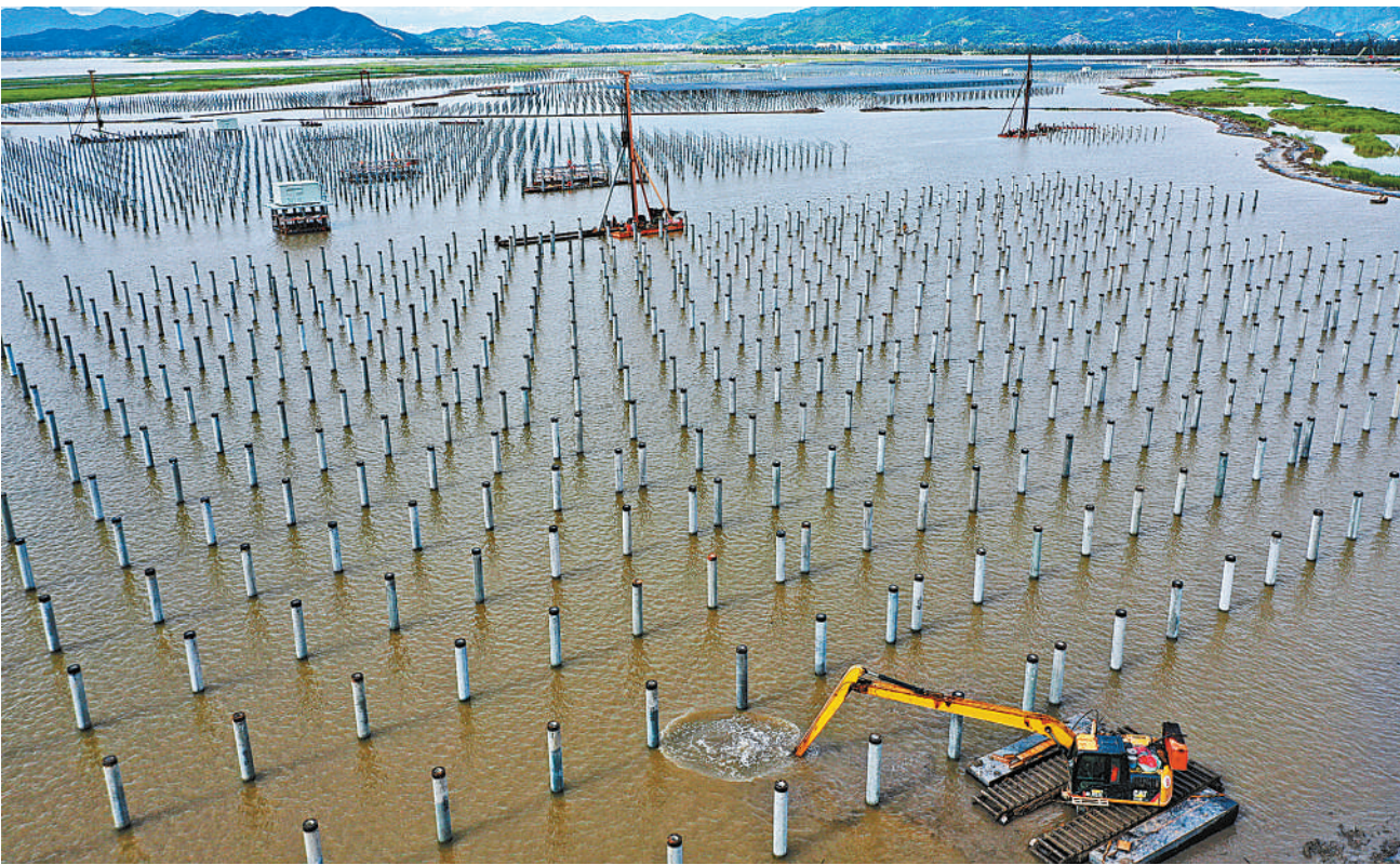
7月19日,浙江玉环市苔山塘1800亩海涂100兆瓦“渔光互补”光伏发电项目工程正在建设中。玉环市在开展光伏发电项目建设的同时,有效利用资源,形成“棚上发电、棚下养鱼”的综合利用新模式,可实现年均发电量约1.4亿千瓦时,每年节约标准煤约4.4万吨,减少二氧化碳排放量11万吨以上。 潘侃俊摄(影像中国)
