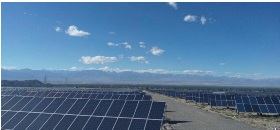
图37：中铁二十局承建伊塞克库尔 1000MW 光伏项目示意图
