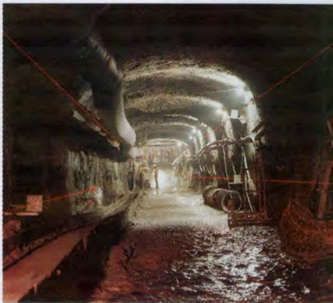
▲ 沿着海峡的隧道两侧，可以看到激光的红色细线。光束从控在隧道墙上的金属板的小孔中穿过。
